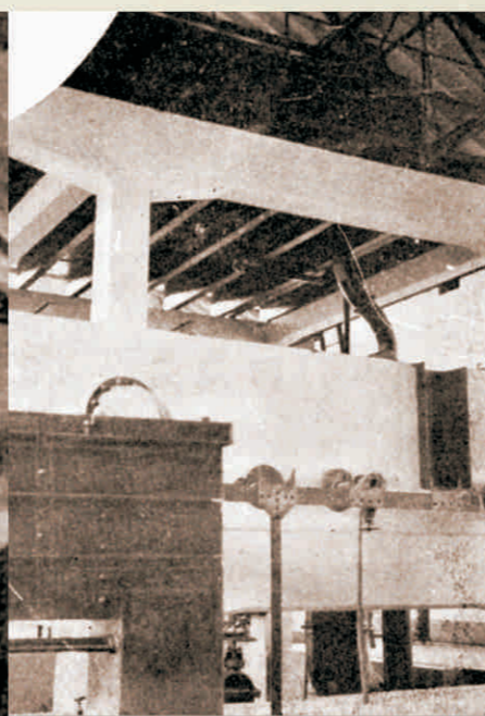
中国第一水工试验所之蓄水池
